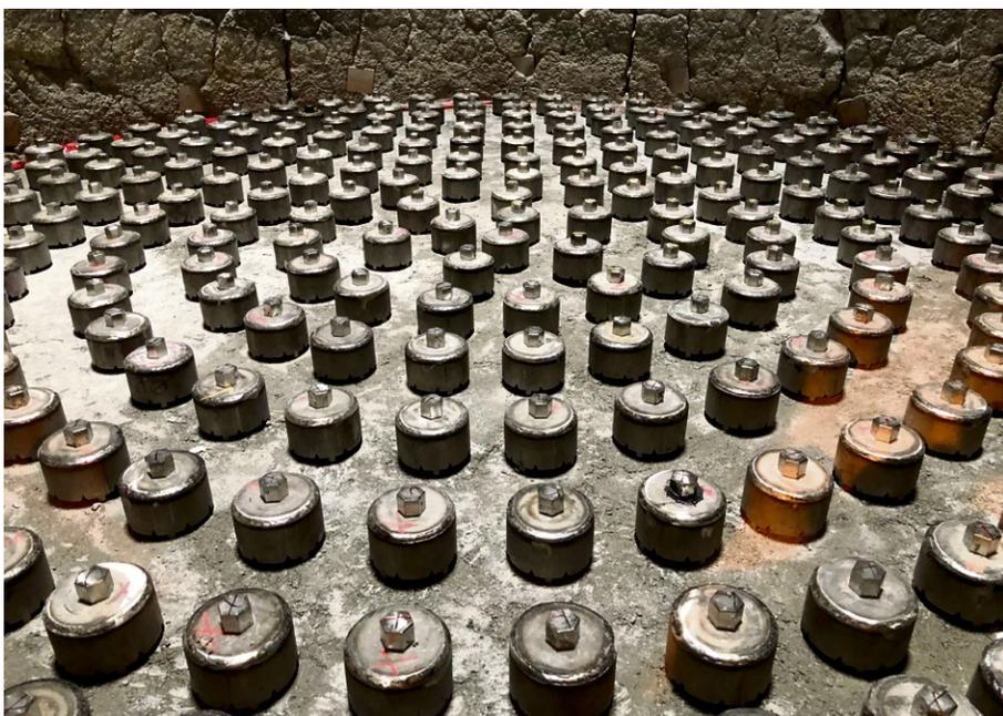
251 tuyères remplacent désormais la membrane du réservoir de rétention d'alumine. Cette technologie assurera une stabilité d'approvisionnement du matériel et une diminution des coûts d'entretien pour le futur.
