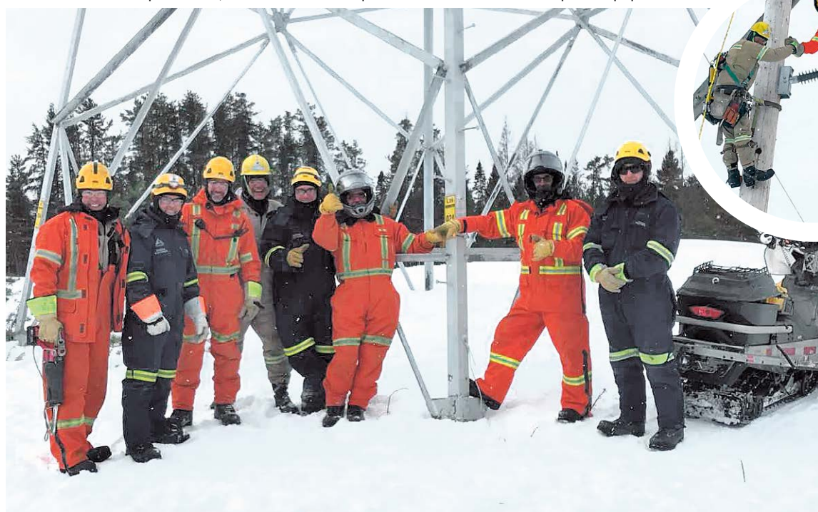
L'équipe des monteurs de ligne d'Énergie Électrique ont remis à niveau les isolateurs des 152 pylônes des lignes 27 et 28, au nord du Lac Saint-Jean.
