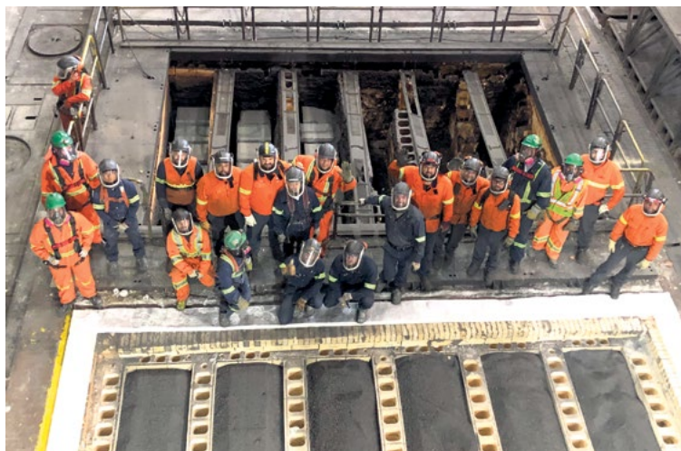
Au total, ce sont plus de 30 personnes qui travaillent chaque jour sur cet entretien d'envergure.
