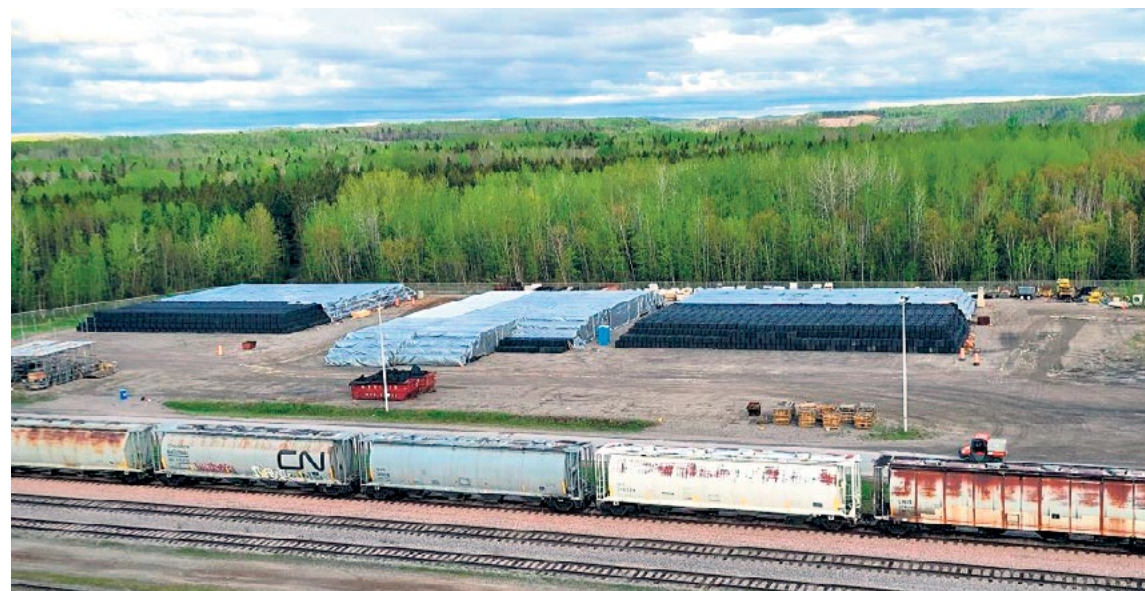
Champ d'anodes aménagés derrière l'Usine Grande-Baie.
