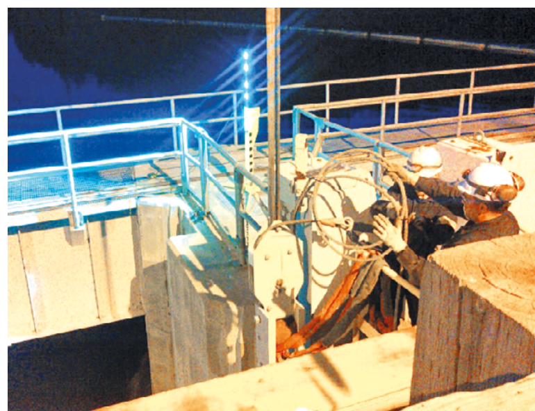
Une équipe de travailleurs a été dépêchée au début du mois de juin pour effectuer une réparation d'urgence sur l'une des 11 vannes de la centrale Chute-à-Caron.
