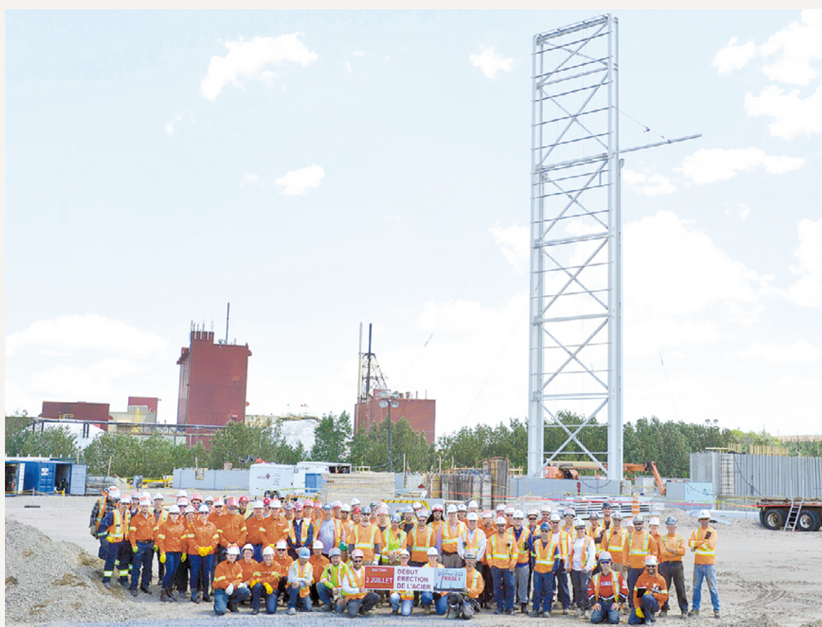
Les employés réunis pour souligner l'érection de la première section de la structure du bâtiment.
