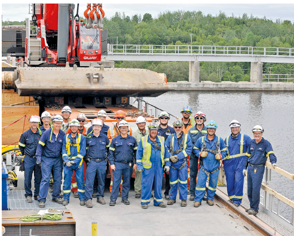
L'équipe de travail pose fièrement devant la vanne de 57 tonnes déposée sur une plateforme.
