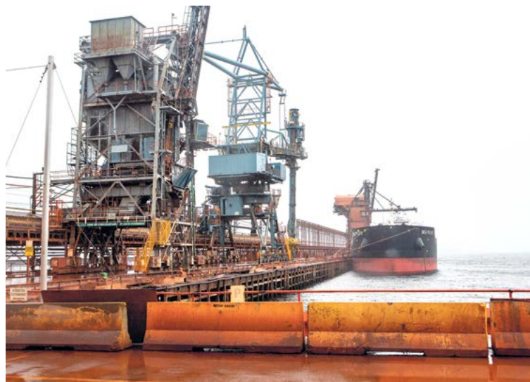
Grâce à une planification rigoureuse, les travaux sur la tour de déchargement d'alumine UT-8 se sont réalisés avec succès.
