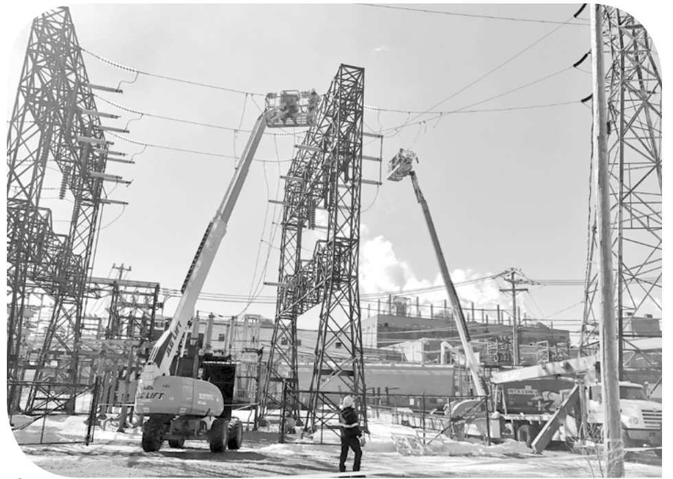
SUR LA PHOTO : Le projet a été réalisé par les monteurs de ligne d'Énergie Électrique, les opérateurs du Poste usines Jonquière et par Dany Gaudreault , superviseur des monteurs de ligne, Denis Côté , technicien à l'entretien, Serge Labeaume , chargé de projet, Kevens Boutin , superviseur Poste usines Jonquière, Marc-André Gagné , surveillant de centre, Carl Fortin , surveillant principal et Jean-François Boulianne , planificateur.
