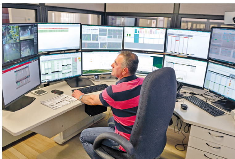
Inauguré en 2015, le Centre opérationnel aluminium se concentre sur deux éléments cruciaux pour la production d'aluminium, soit la vigie du procédé d'électrolyse et la gestion du métal. Unique dans l'industrie de l'aluminium, il assure un soutien technique et une expertise en temps réel 24 h sur 24, sept jours sur sept aux quelque 3 000 cuves des opérations Atlantique de Rio Tinto. Il permet également la planification et la coordination de la distribution du métal chaud.
