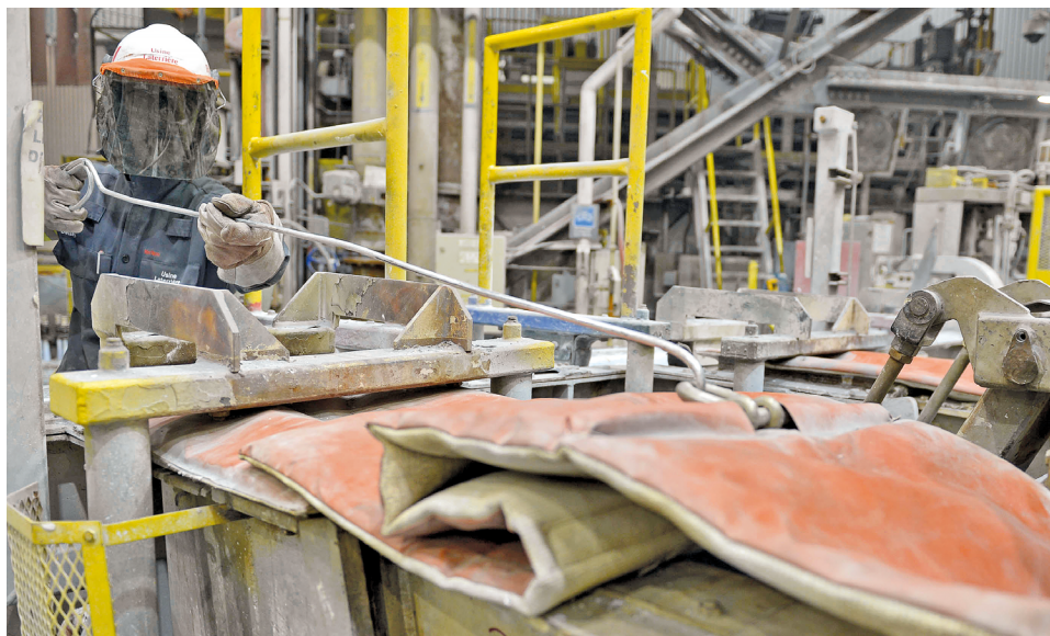
La nouvelle couche isolante est maintenue en place par des aimants et rétractable à distance avec une tige de métal.
